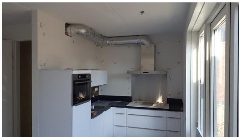
Figuur 12 afzuigkap in keuken en 180 mm kanaal.
