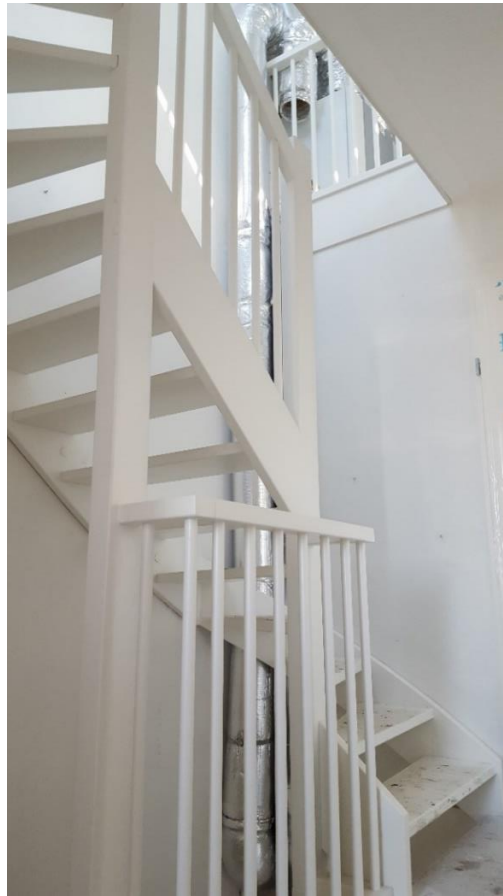
Figuur 13 afzuigkanaal in lepe hoek trappenhuis.
